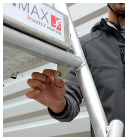
Comprobar que el gancho se sitúa correctamente por debajo de la plataforma
