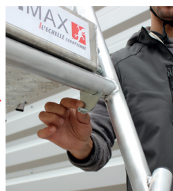
Vérifier que le crochet prenne bien le montant sous la plate-forme
